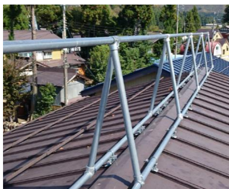
①-1 固定アンカー(単管型)
