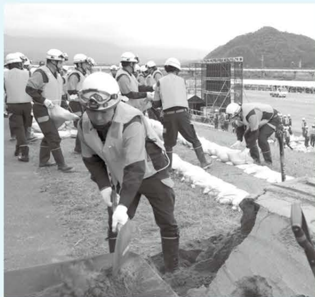
上越三市の消防団が堤防被害を想定した 水防工法の演習を行いました
