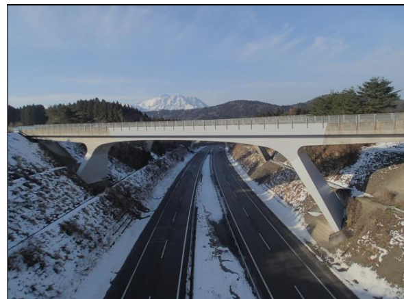
写真全景 (コンクリート橋)
