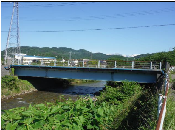
写真全景 (鋼橋)
