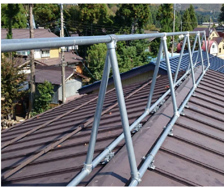
①-1 固定アンカー(単管型)
