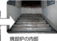
焼却炉の内部
