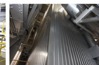
⑨集じん器 熱回収しながら冷やされた排ガスは、集じん器に配置されている、「ろ布」というフィルタを通り、ばいじんなどの有害物質がとり除かれ、煙突に送られます。
