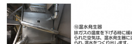
健康づくりセンター 熱エネルギーを回収して温水発生器でつくられた温水が、場外の健康づくりセンターの風呂やプールなどで利用されます。
