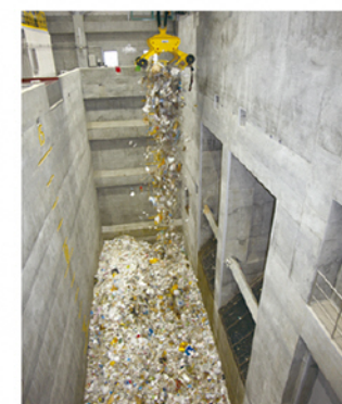
⑤ごみピット およそ深さ9m×幅21m×奥行7mで、1,300立方メートルのごみを貯めることができます。
