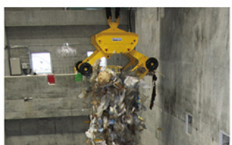
⑥ごみクレーン 大きな爪でごみをつかんで持ち上げ、バケットを開きごみを投下します。これを繰り返して生ごみや紙、プラスチックなど、ごみの偏りがなくなるように混ぜ、均一に燃やせるようにします。
