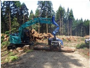
〈スギ人工林の伐採作業〉
