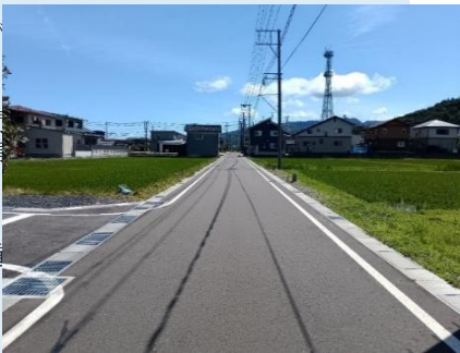
新設された市道大排水路線
