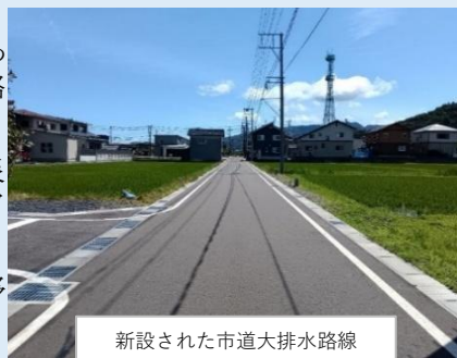
新設された市道大排水路線
