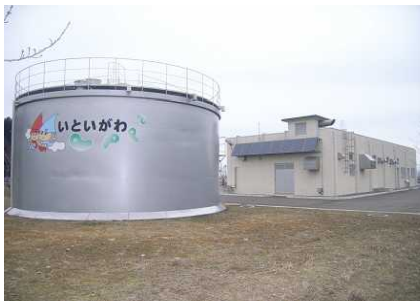
環境に配慮した梶屋敷水源池
