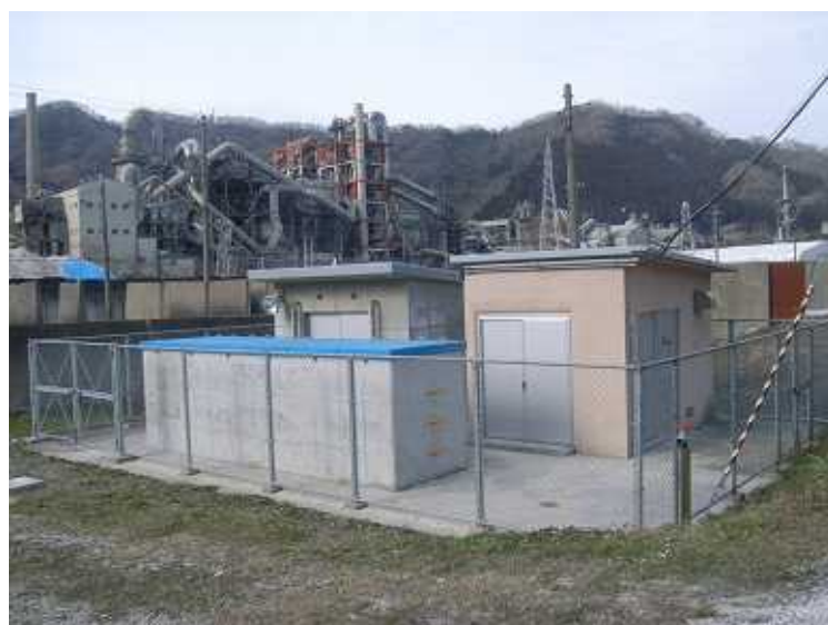
青海大沢水源地
