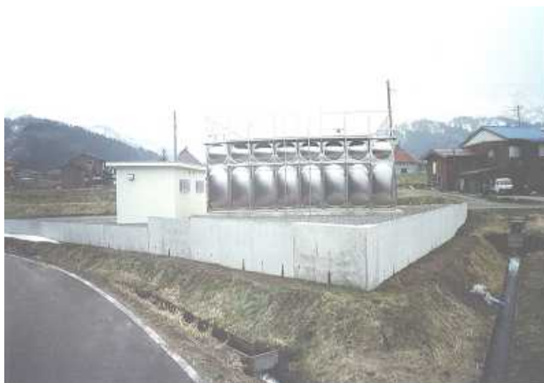
早川簡易水道 第二配水池
