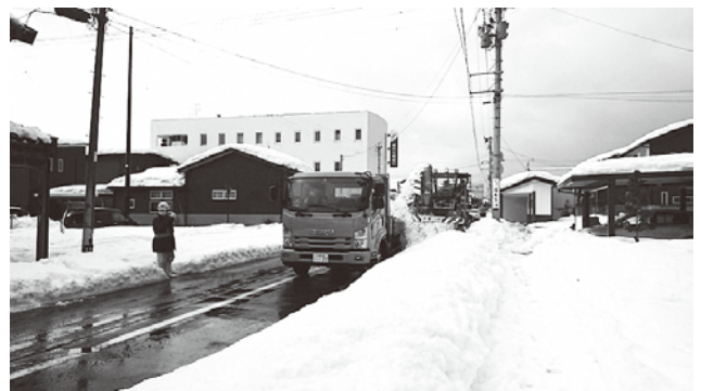
除雪作業の様子
